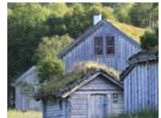
Stavanger Turistforening fekk byggeskikkprisen i 2002 for nybygg og restaureringsarbeid på Bleskestadmoen.
