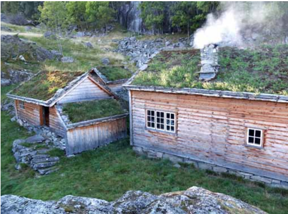
Husmannsplasset Røynevarden ved Suldalsvatnet er restaurert av Ryfylkemuseet og er eit av museet sine anlegg.
