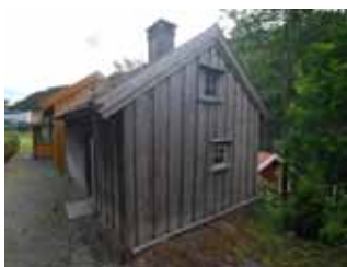
Under: Den vesle Karistova ved Osbakkjen på Sand, i verneklasse B og fint restaurert.
